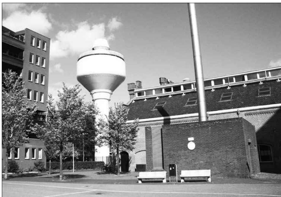
Fot. 1. Dawna wodociągowa wieża ciśnień – obecnie punkt widokowy i symbol tożsamości miejsca, fot. Bogusław Wojtyszyn
