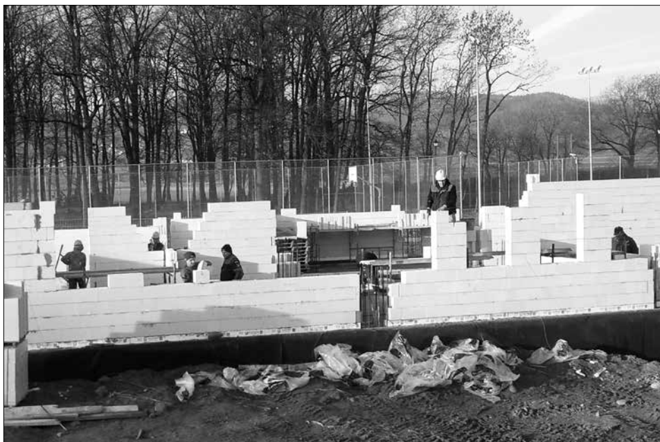
Fot. 2. Budowa ścian, fot. Małgorzata Chmiel
