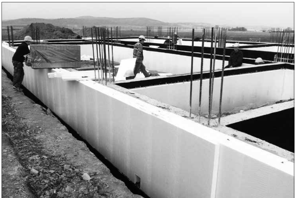
Fot. 1. Budynek szkolny powoli wylania się z ziemi, fot. Małgorzata Chmiel
