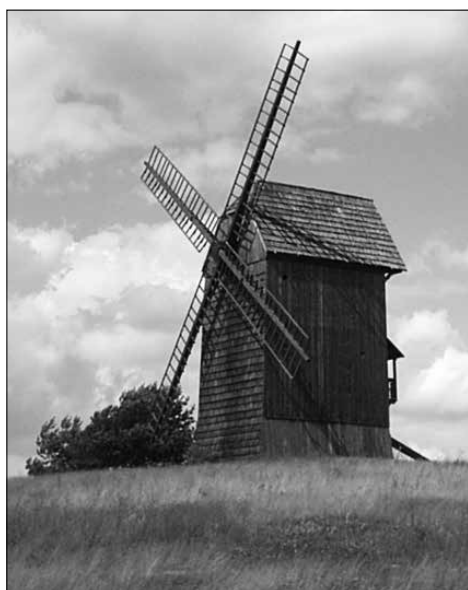
Rys.1. Wiatrak koźłowy (koźlak) w Lednogórze (źródło wikipedia.org)
