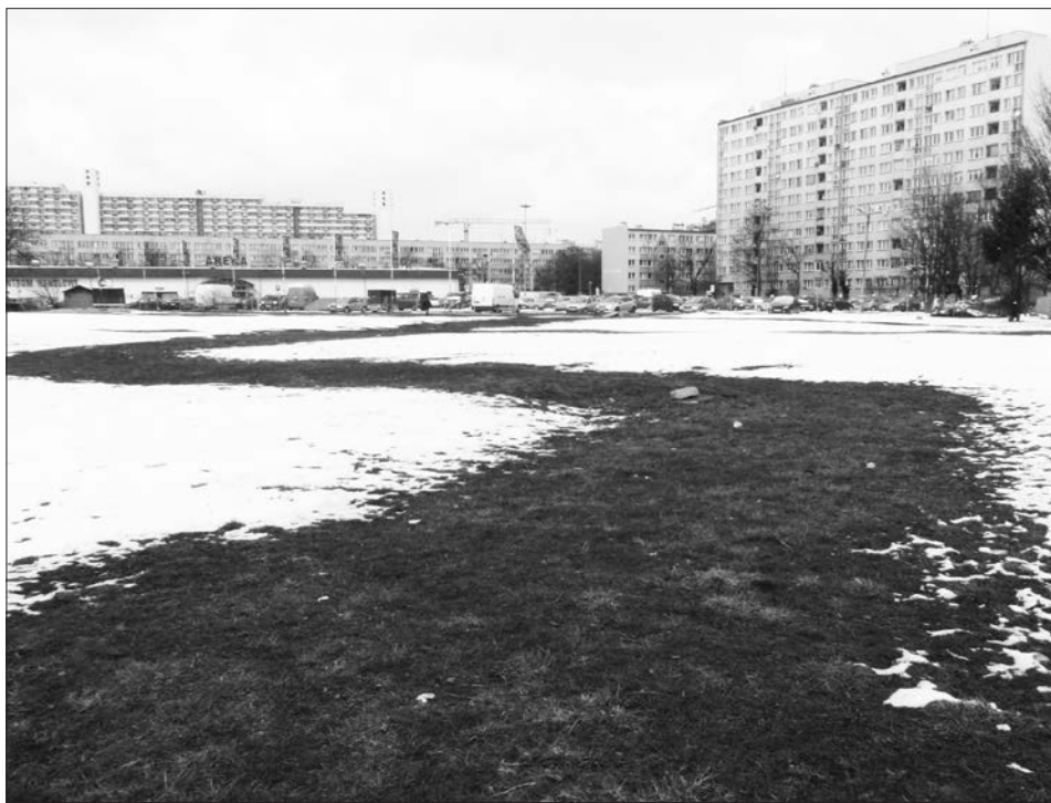
Fot. 2. Wytopiony śnieg nad liniami ciepłowniczymi – to strata energii, fot. Aureliusz Mikłaszewski
