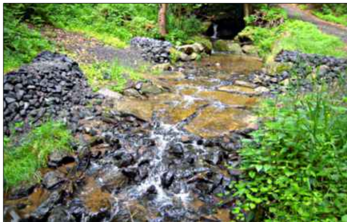
Fot. 10. Bród przejazdowy, umocniony miejscowym, naturalnym kamieniem, podpiętrzający wodę w Nadleśnictwie Lwówek Śląski. Fot. Ryszard Majewicz
