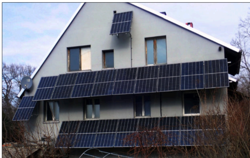
Fot. 1. Dom prosumenta obudowany panelami. Fot. Aureliusz Mikłaszewski
