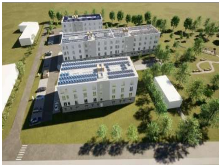
Fot. 14. Wizualizacja projektu TBS na Praczech Odrzańskich – rozwiązania błękitno-zielone służące do zagospodarowania wód opadowych oraz odnawialne źródła energii – Wrocławski Standard Zielonego Budynku.
