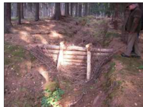
Fot. 1. Opóźnianie spływu powierzchniowego w górach poprzez zabudowę nieczynnego szlaku zrywkowego w Nadleśnictwie Jugów. Fot. Ryszard Majewicz
