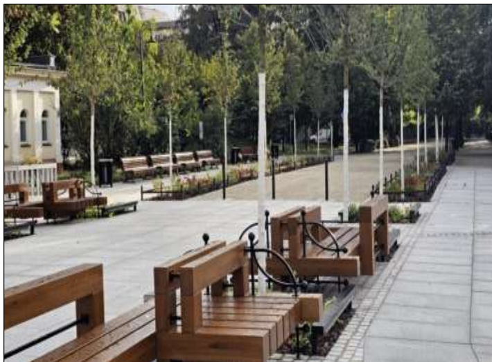
Fot. 10. Błękitno-zielona infrastruktura na placu wejściowym na Promenadę Staromiejską w rejonie Pomnik Bolesława Chrobrego.
